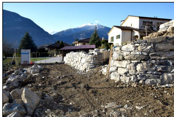
Préparation, fourniture des matériaux
