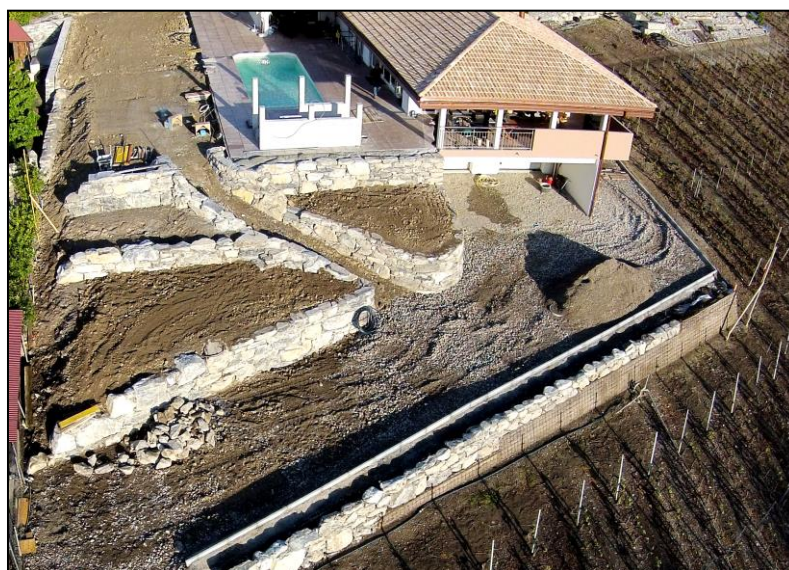
Finitions, couronnements des murs, et remblayages
