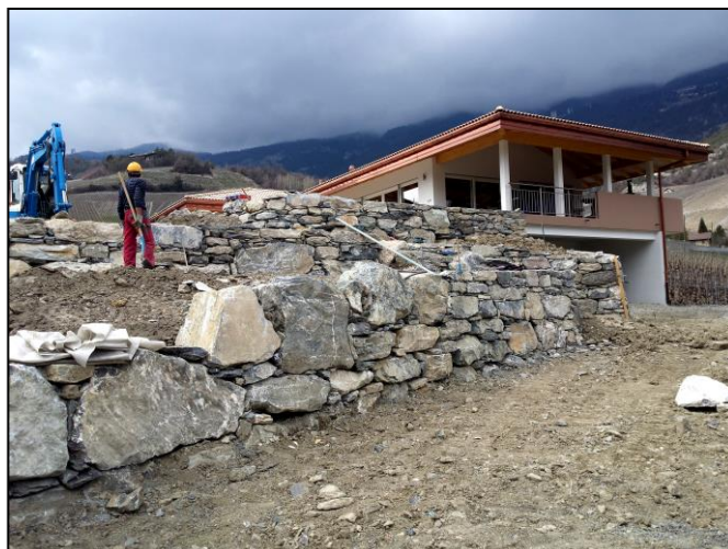
Taille des pierres et montage des murs
